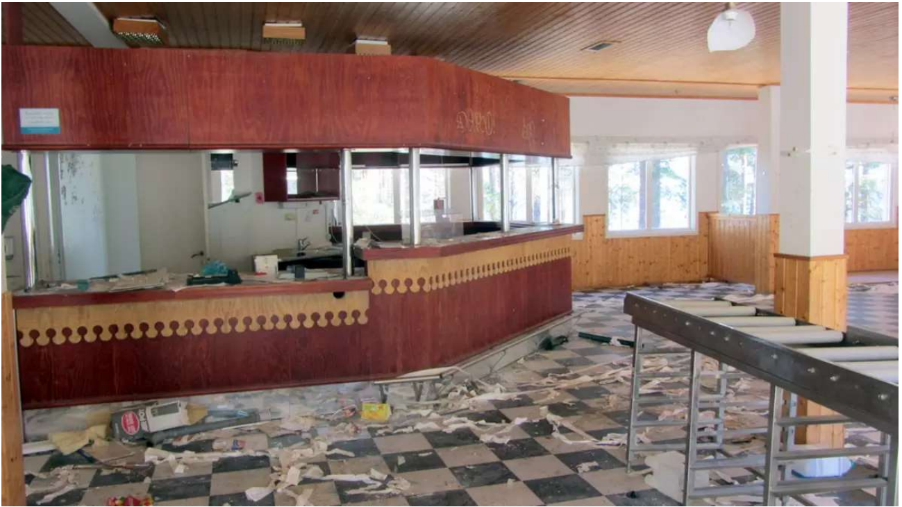
Vanha päärakennus on kymmenessä vuodessa kokenut kovia. Kuva: Yle Petri Kivimäki
